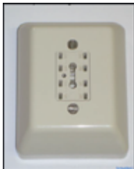
ADo 8: Wandsteckdose (Aufputz)
